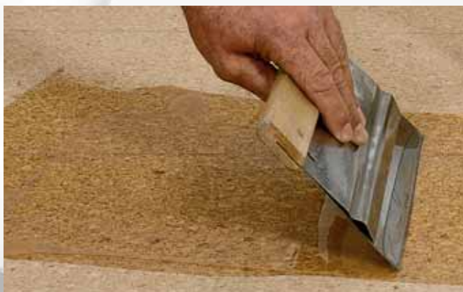
6. Первый слой нанести двусторонним шпателем и распределить равномерным тонким слоем
