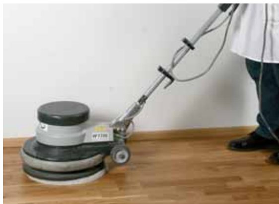
12. Разравнивание с помощью однодисковой машины (белый пад)
