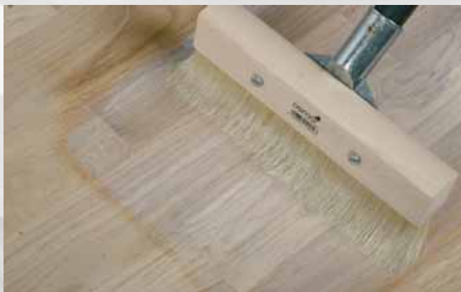
8. Нанесение масла-белой грунтовки (3040) специальной щёткой
