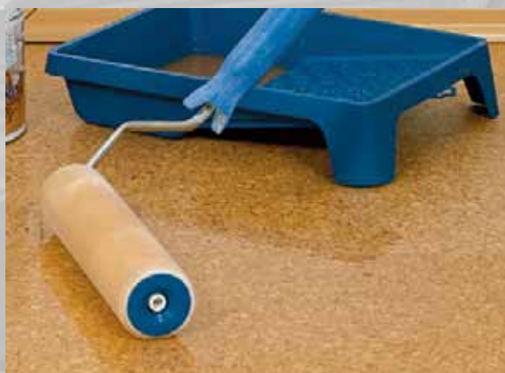
7. Второй слой нанести мохеровым валиком с коротким ворсом и распределить тонким слоем
