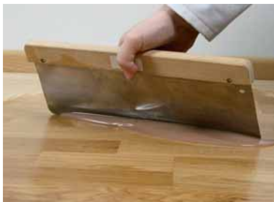
11. Нанесение масла Polyx Hartwachs-Öl двусторонним шпателем
