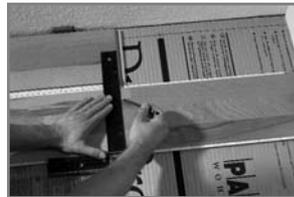
4. Последнюю панель первого ряда отрезать до нужной длины, при этом учитывается расстояние до стены. Отрезанный кусок панели используется для начала второго ряда.
