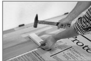
6. Соедините торцевые стыки с помощью молотка и монтажного бруска. При этом продольные и торцевые канти фиксируются автоматически. Продолжить укладку по всему помещению.
